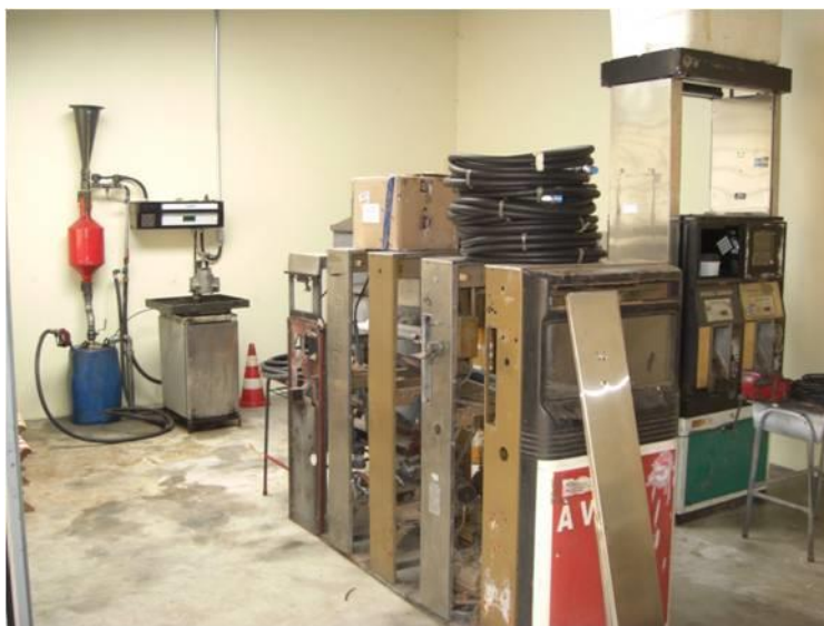
Ilustração 12: Estrutura física da oficina
