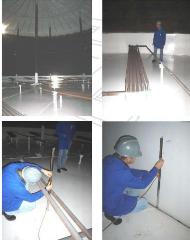
Figura 12 – Técnica da fita métrica (Medidas internas) – Estruturas internas e topografia do fundo
