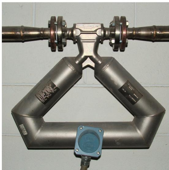
FIGURA 1. Medidor por efeito Coriolis.
